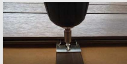
» El sistema de fijación mediante clips ocultos garantiza la ventilación del pavimento y permite el drenaje del agua por debajo de la superficie.
